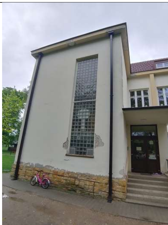
VÝMĚNA SCHODIŠŤOVÉHO OKNA V ZÁPADNÍ FASÁDĚ
