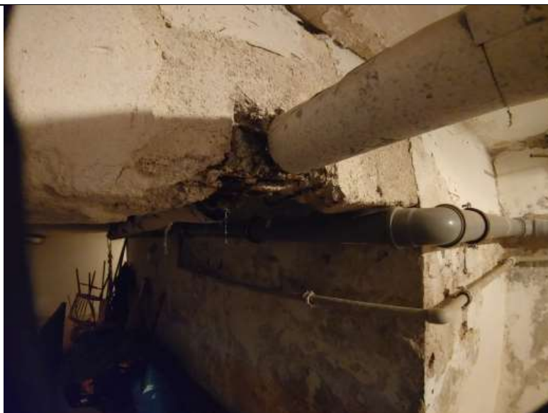
POŠKOZENÝ PRŮVLAK V 1. PP
